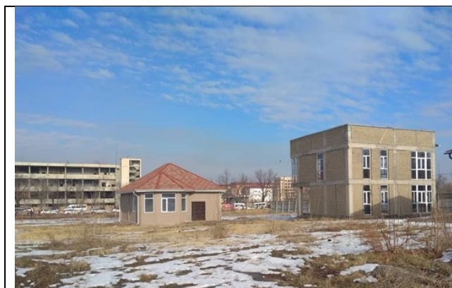
Строительство демонстрационных домов из местных строительных материалов
