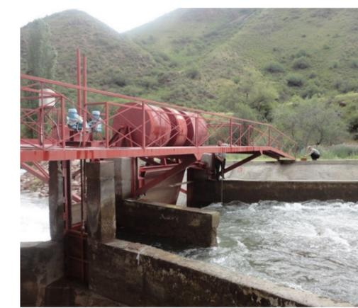
*Водозаборное сооружение, внедренное на реке Мерке РК, для подачи воды на деривационную ГЭС*
