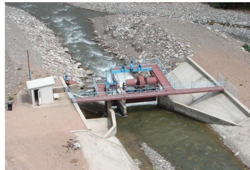
Водозаборное сооружение для деривационной ГЭС, построенное в 2007 г. на реке Иссык-Ата
