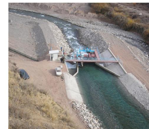
*Водозаборное сооружение, внедренное на реке Иссык-Ата, для подачи воды на деривационную ГЭС*
