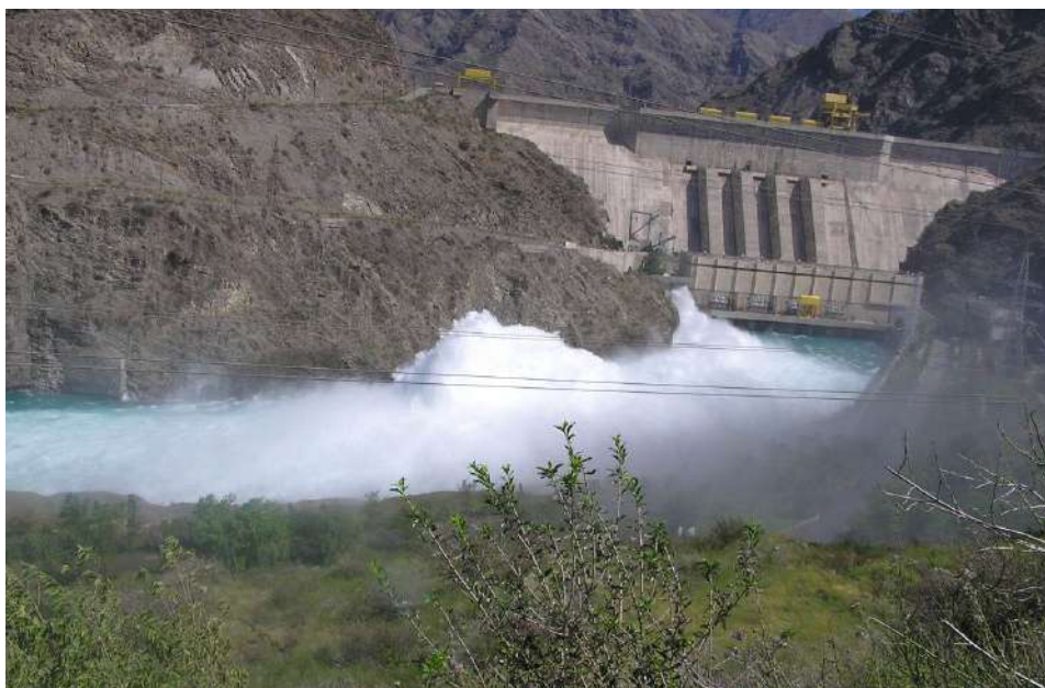
Сброс воды через береговой водосброс Курпсайской ГЭС
