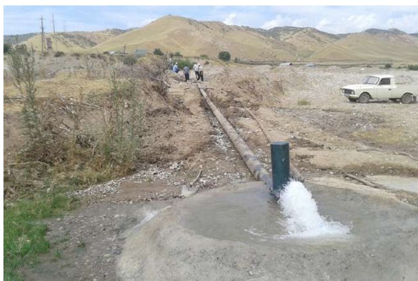
Внедрение гидравлического тарана ГТ-200 на реке Кара-Ункур для орошения сада лесхоза "Ачы"
