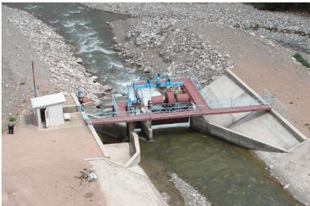
Водозаборное сооружение с устройством для рыбозащиты на р. Иссык-Ата
