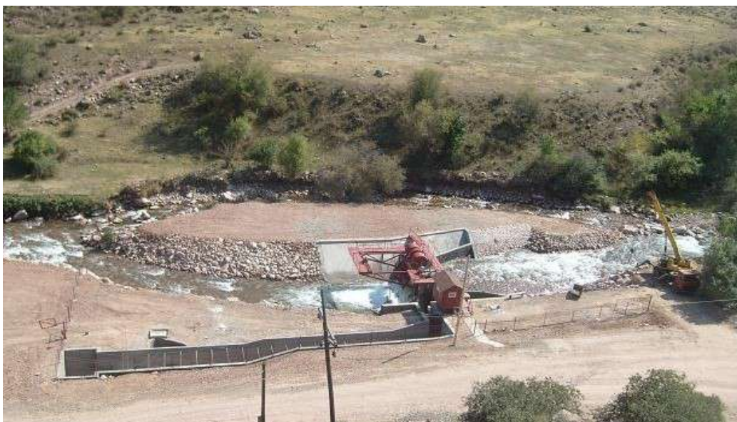
Водозаборное сооружение для Меркенской МГЭС-3. Построено в 2010 г.
