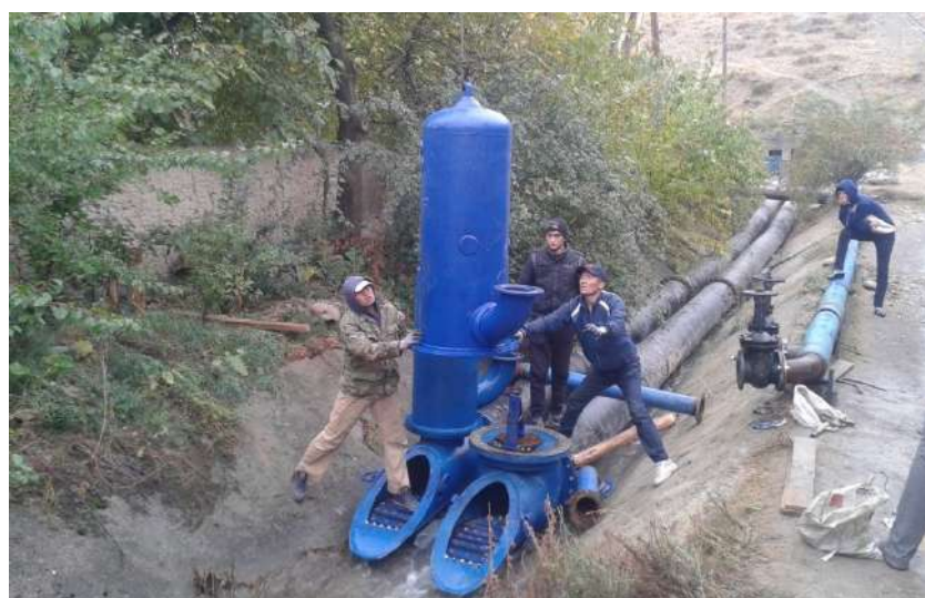
Монтаж установки гидравлического тарана на холостом водосбросе канала Кожо-Каир
